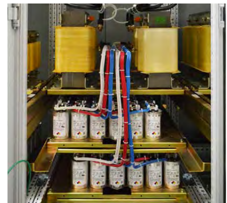
› Disposición de reactores en filtro automático
