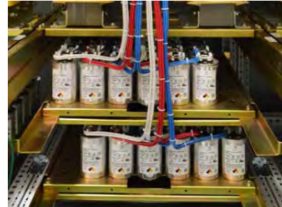
› Arreglo de celdas capacitivas en filtro
