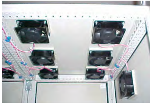
› Extractores de calor para filtro de armónicas
